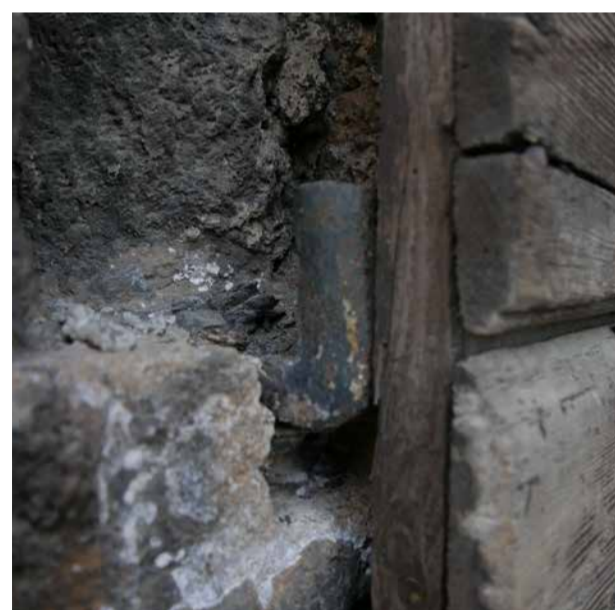
Gond de scellement (penture manquante)
