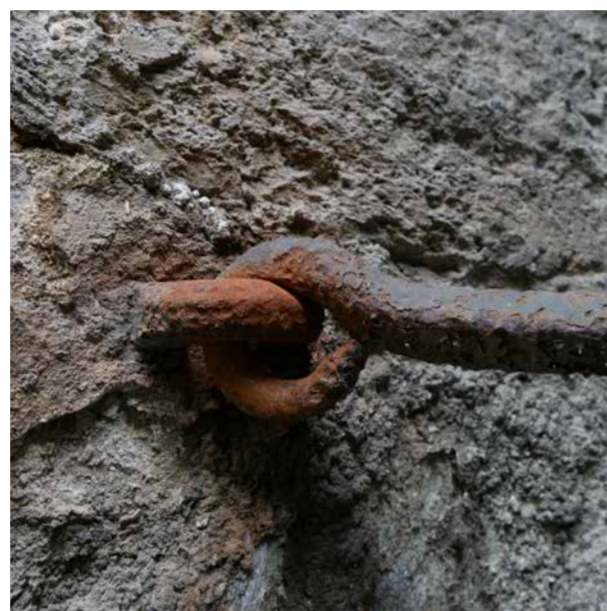
Anneau forgé-scellé & barre forgée
