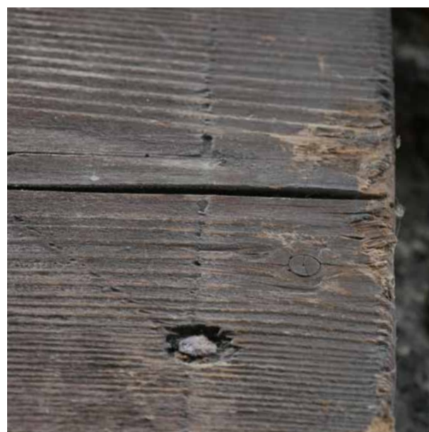
Marque visible de la pointe à tracer
