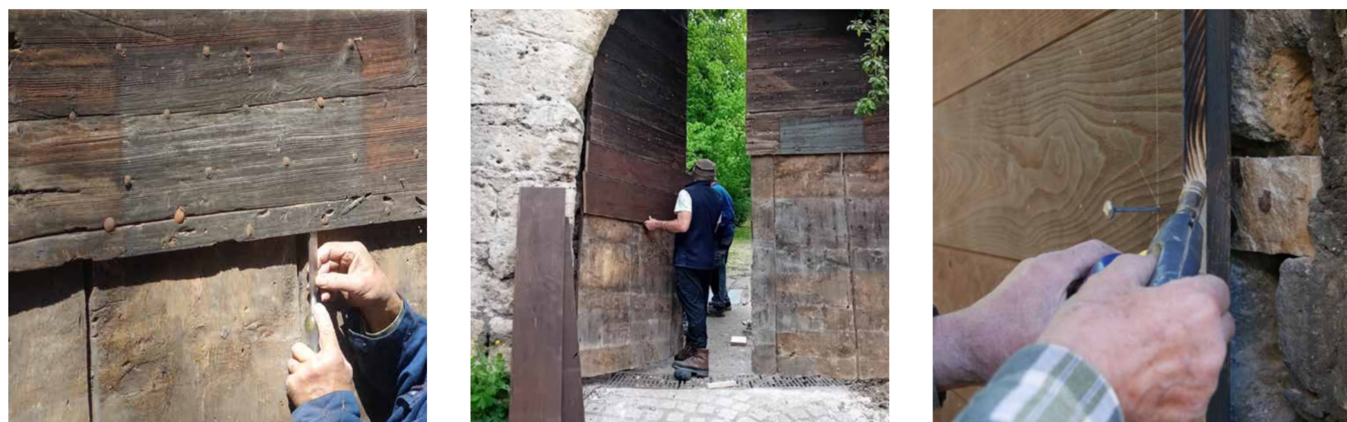
Dégagement des planches, préparation du support (y compris rainure) et fabrication des nouvelles planches ( finition brulée pour teinte)
