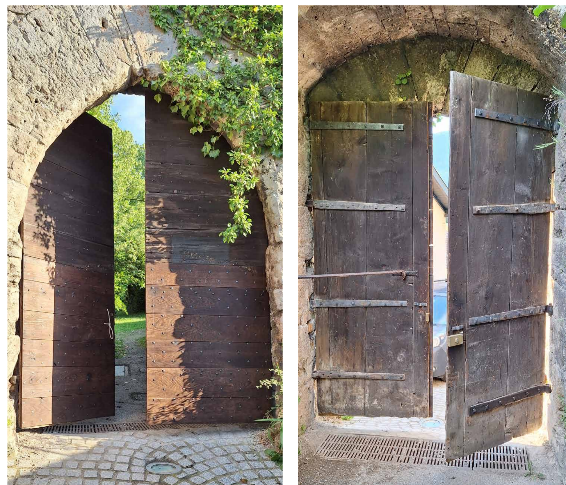
Vantaux côté externe (porte face extérieure), vantaux côté interne (porte face intérieure) restaurés : planches horizontales en châtaigner, brûlées et clouées ; presque 300 clous forgés et restitution de la trame losange originelle ; pentures forgées, scellements et reprises de maçonnerie.
