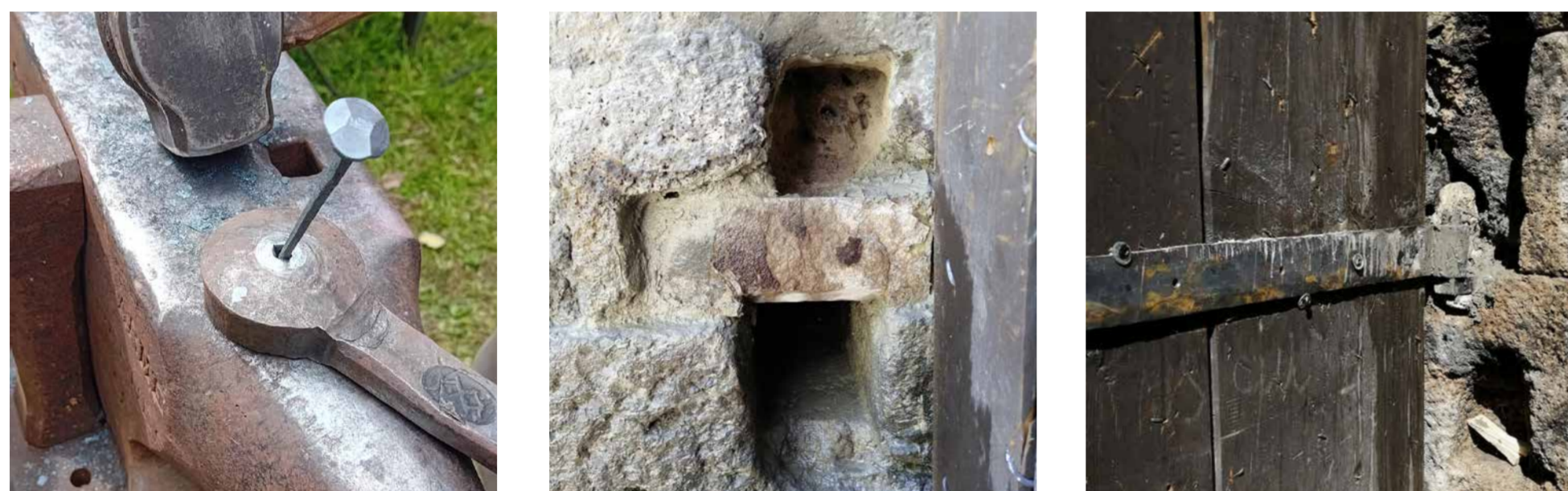
Forge des ferrures et clous, reprise de maçonnerie, redressement des vantaux et mise en place des pentures nouvellement forgées
