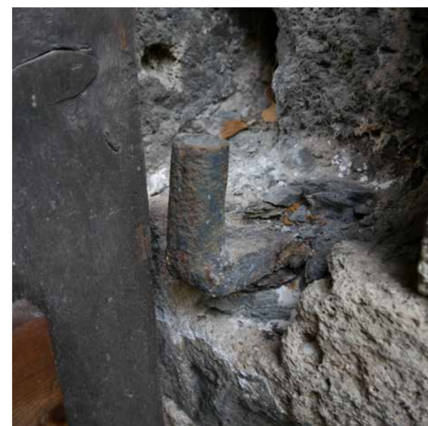
Gond de scellement (penture manquante)
