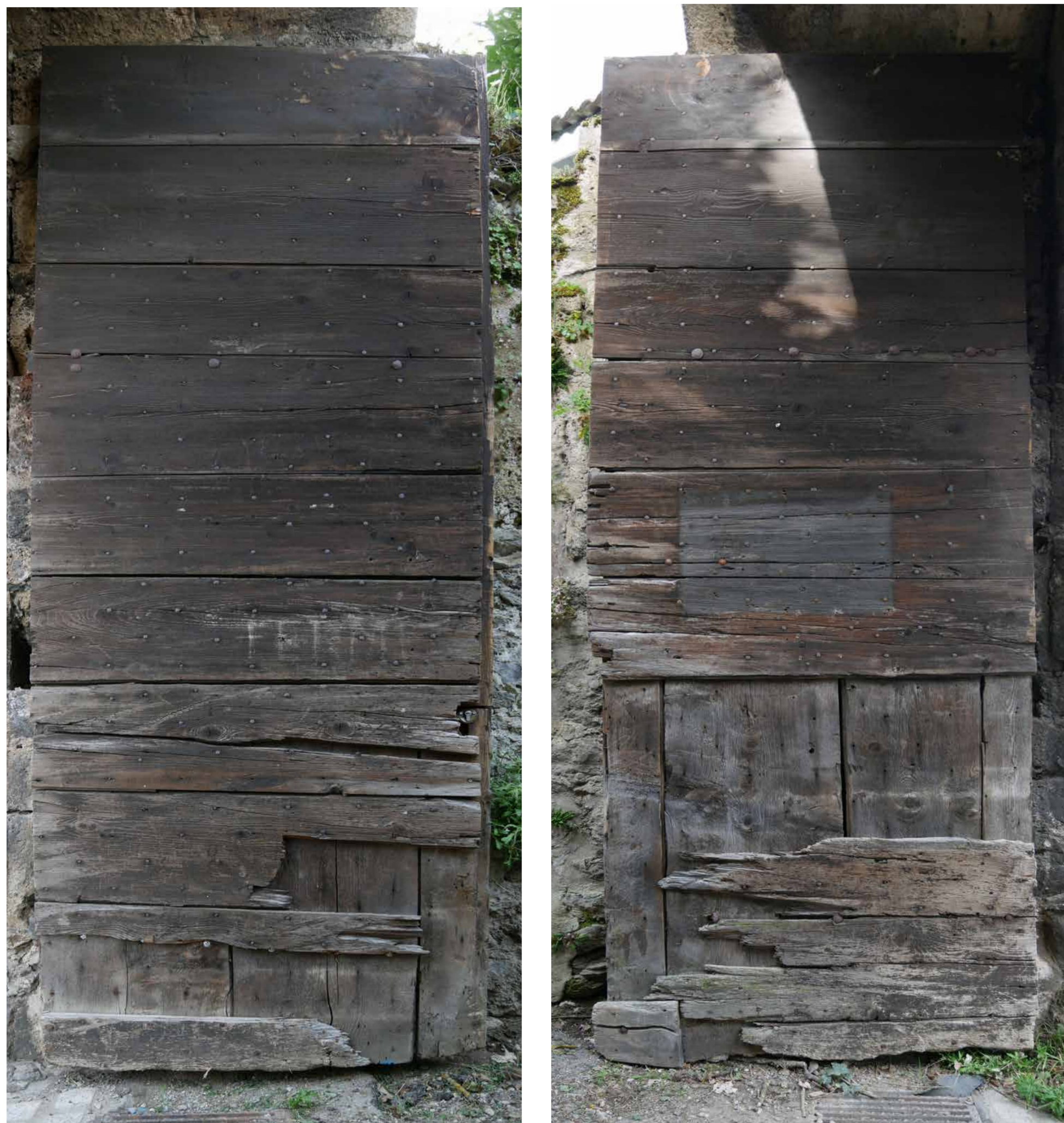
Vantail gauche ; Vantail droit (externe) : les planches horizontales dépassent le montant pour former la battue qui viendra recouvrir le montant du second vantail
