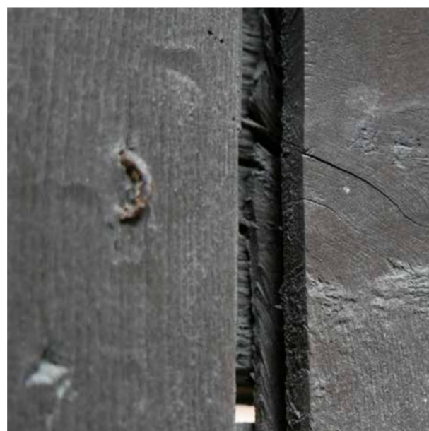
Rainure visible de la planche verticale
