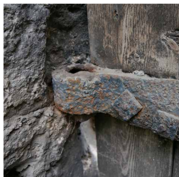
Penture et écrous carrés forgés
