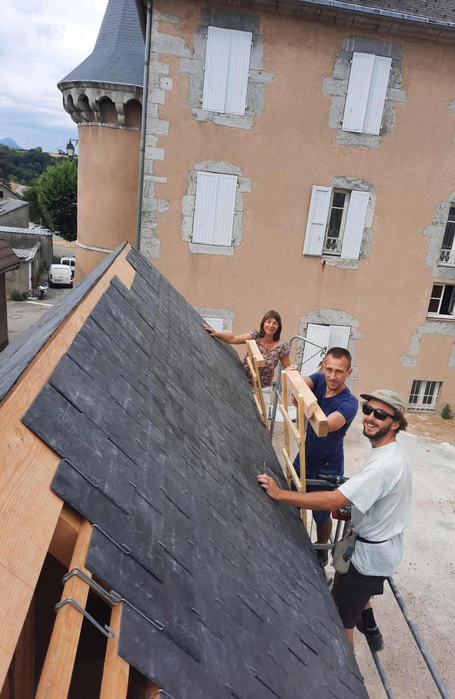
Couverture ardoises posées aux crochets
