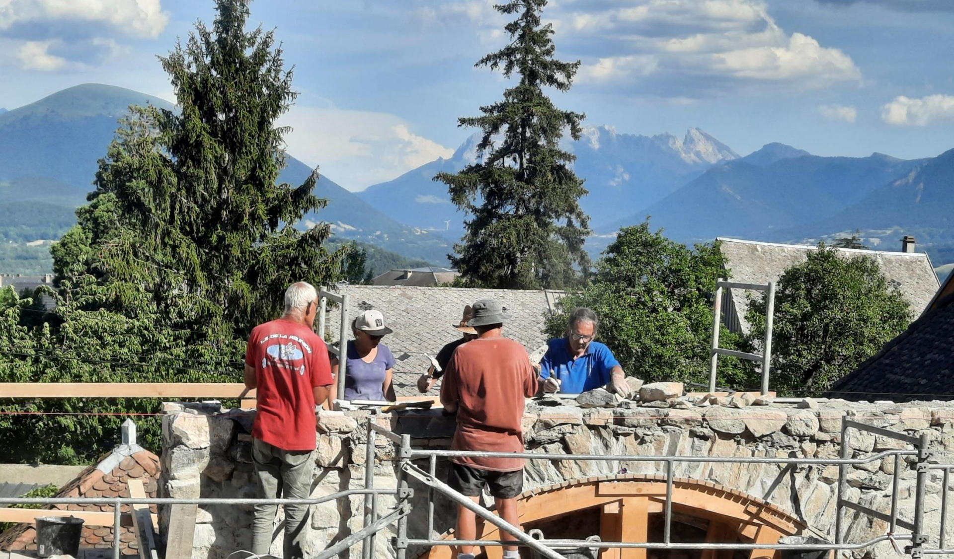
On termine l'arase sommitale avant de mettre en place la charpente
