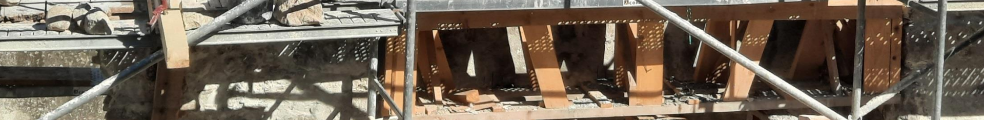
On termine l'arase sommitale avant de mettre en place la charpente
