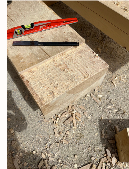
les étapes de découpe du tenon de l'enfourchement
