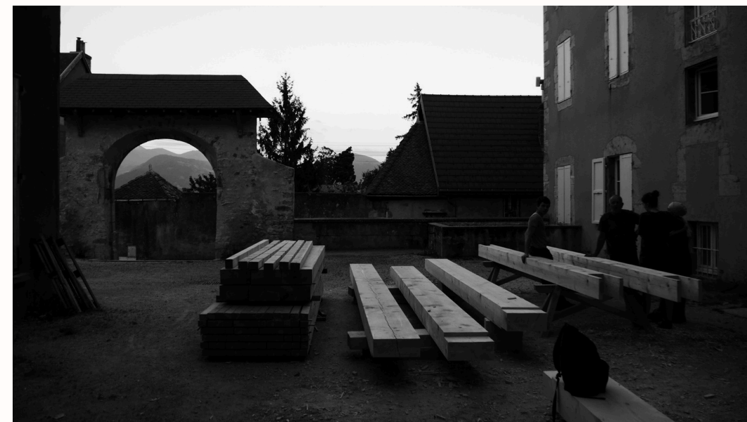
cour du chantier : atelier charpente
