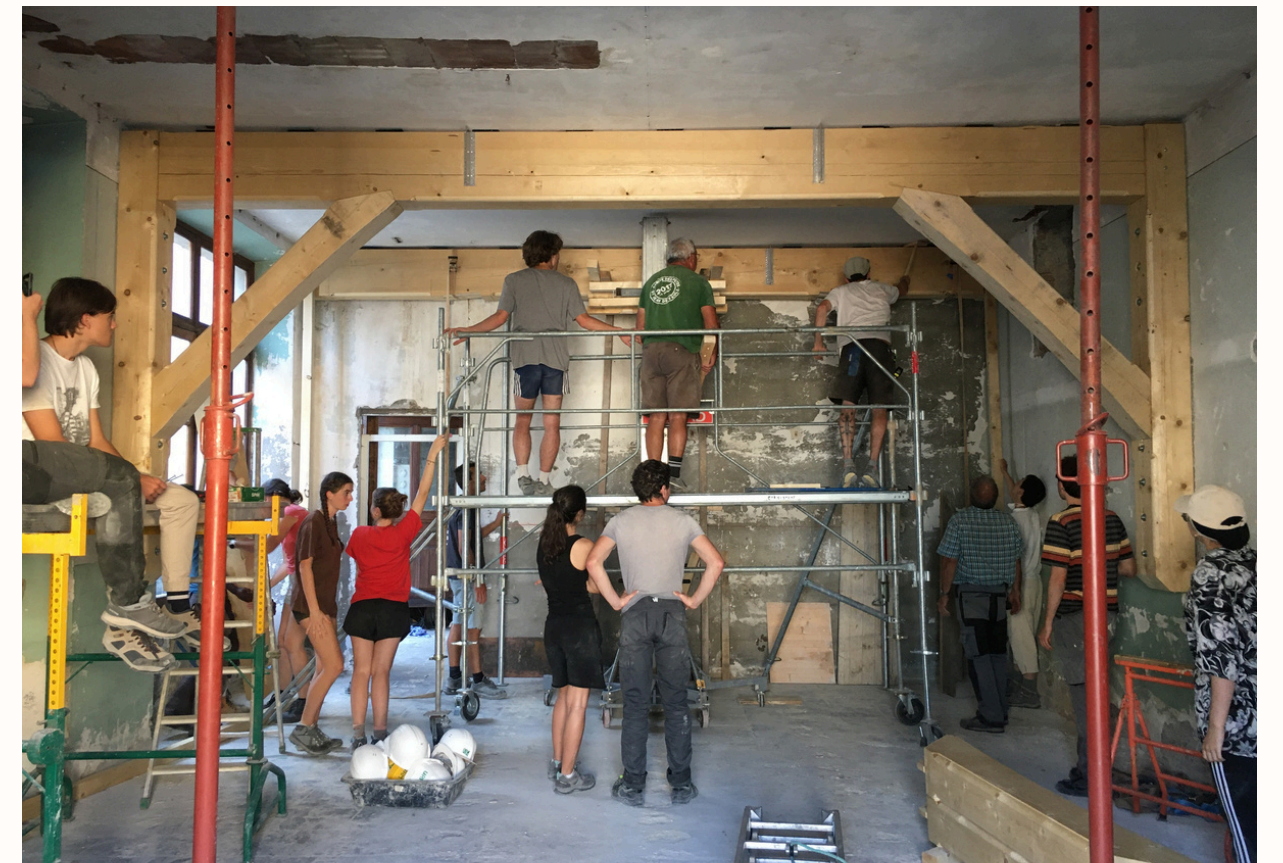
opération de levage d'un portique périphérique – dernier jour du chantier
