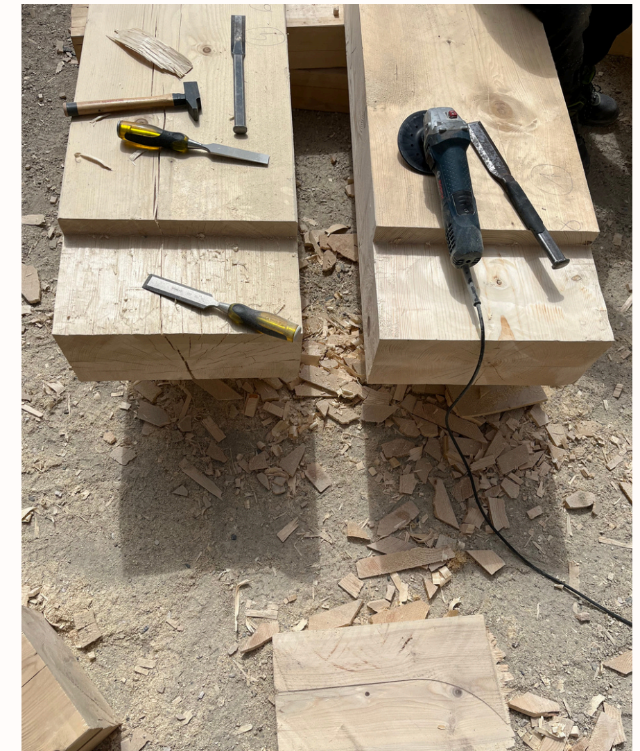
poste de travail et outils nécessaire pour la taille de l'enfourchement des porteurs
