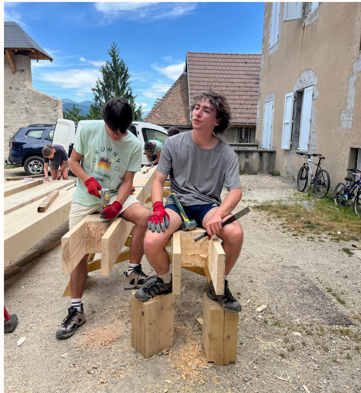
stagiaires taillant des assemblages (enfourchements et embrevements)
