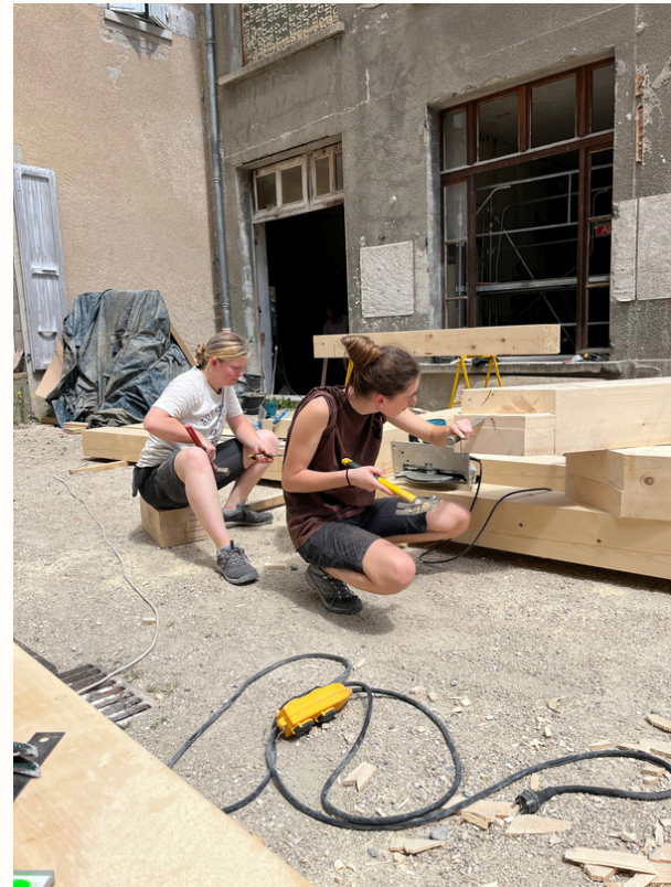
stagiaires taillant des assemblages (enfourchements et embrevements)
