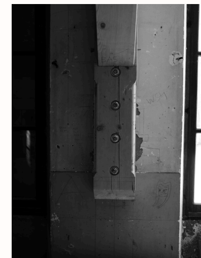
perçage du mur à travers les porteurs
