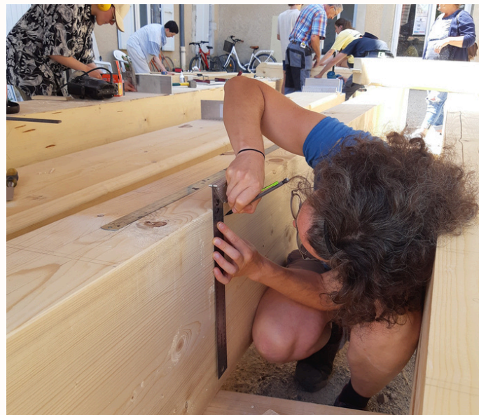
traçage des repères de découpe des mortaises
