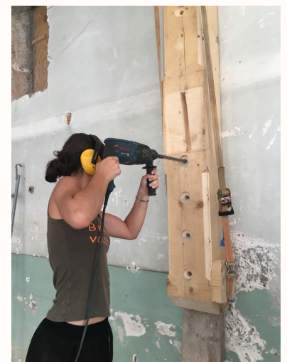
perçage du mur à travers les porteurs
